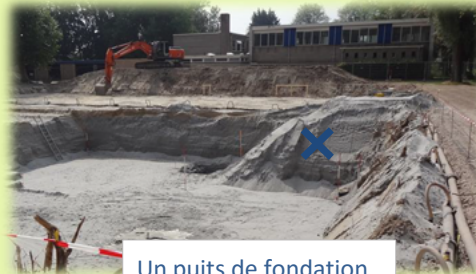
Un puits de fondation
